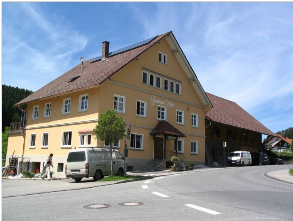
Unser Haus kurz nach den Malerarbeiten 2004
